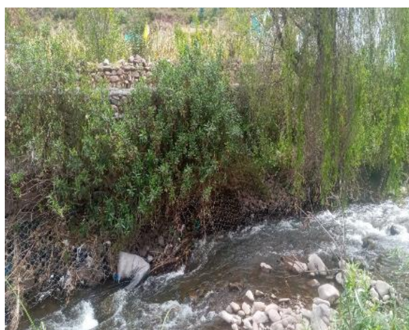
FIGURA N°02: : Se Aprecia AL PIE DE TALUD DEL GAVION AFECTADO POR ZOCAVAMIENTO, MARGEN DERECHA AGUAS ABAJO DEL RIO QUEHUARMAYO Y ASI MISMO SE ENCUENTRA COLMATADO CON MATERIAL SOLIDO, PENDIENTE MUY FUERTE.
